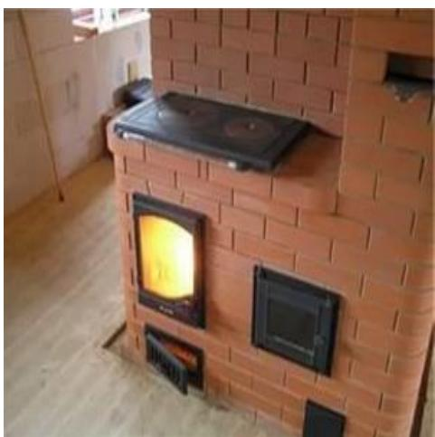
***Во-первых***, нарушение правил устройства печи: недостаточные разделки дымовых труб в местах их прохождения через деревянные перекрытия, а также малые отступки - расстояния между стенками печи и деревянными конструкциями перегородок и стен дома; отсутствие предтопочного листа. Под печь возводится самостоятельный фундамент.
